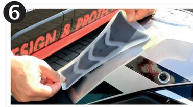
Das Material beim Verkleben **NICHT durch ziehen auf Spannung** bringen!
